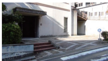
車いす送迎専用駐車場の設置
