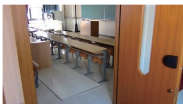
教室内の車いすスペースの確保
